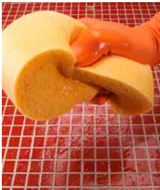
Prima di procedere alla pulizia bagnare la superficie stuccata.
